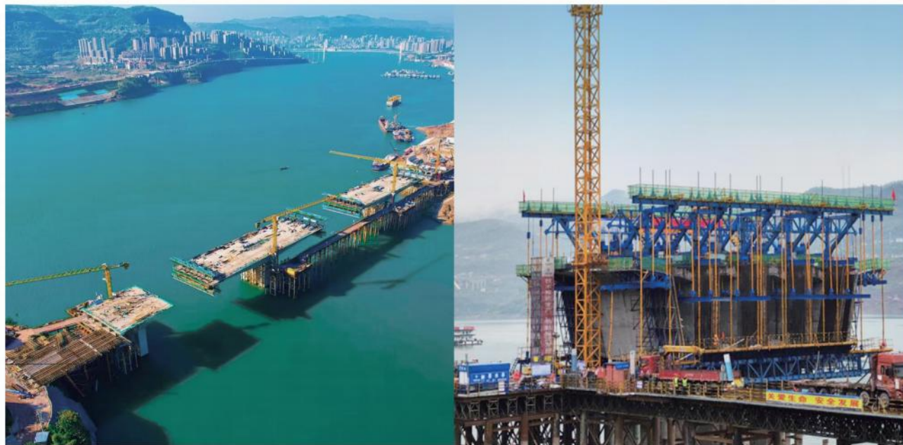
恒太河大桥施工监测
