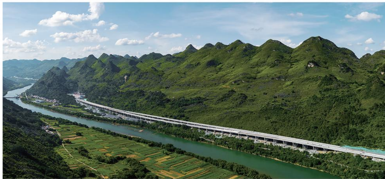
广州—连州高速公路超前地质预报；定期检查及公路技术状况评定服务；安全检测；中心试验室；工地试验室
