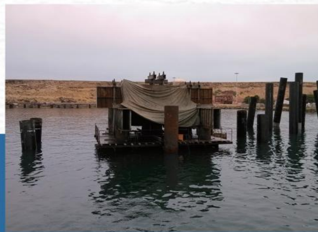
安哥拉纳米贝湾 突提卸油码头项目桩基检测
