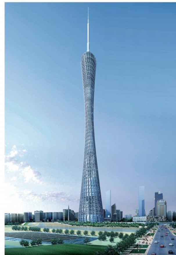
广州新电视塔（广州塔）外部 钢结构防腐涂装工程
