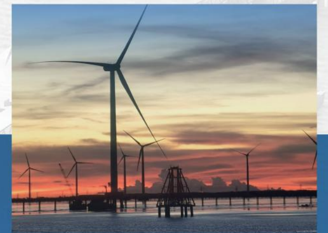
越南薄寮三期、朔庄一期海上风电项目 桩基承载力试验检测；技术咨询
