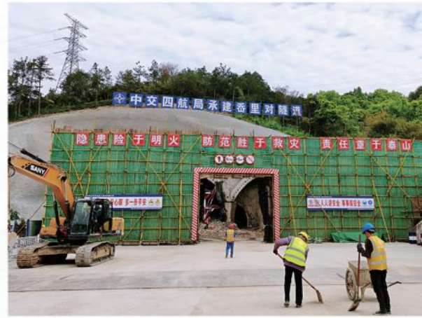
台州余温公路院桥支线PPP项目 岙里对隧道超前地质预报
