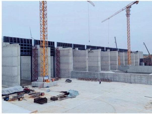
唐河省界至社旗航运工程 (省界至马店段) 施工安全监测
