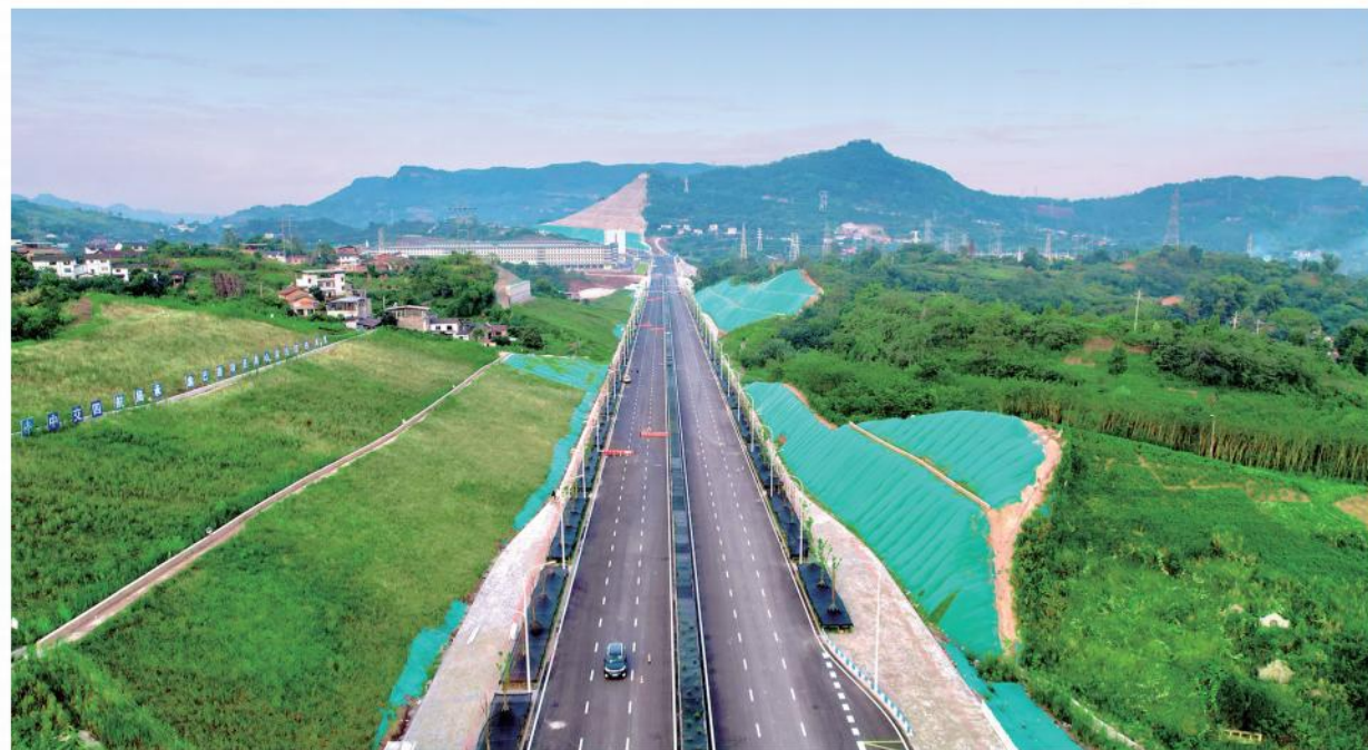
万安枢纽二线船闸主体土建工程裂缝控制
