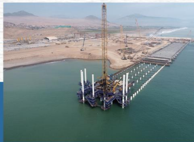
秘鲁钱凯综合港 桩基检测、地质勘察、边坡技术咨询
