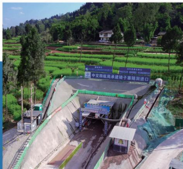
亭子口水利枢纽工程第IV标 骑子寨隧道超前地质预报
