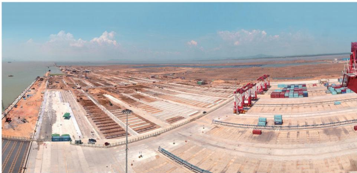
广州港南沙港区三期工程地基处理试验区
