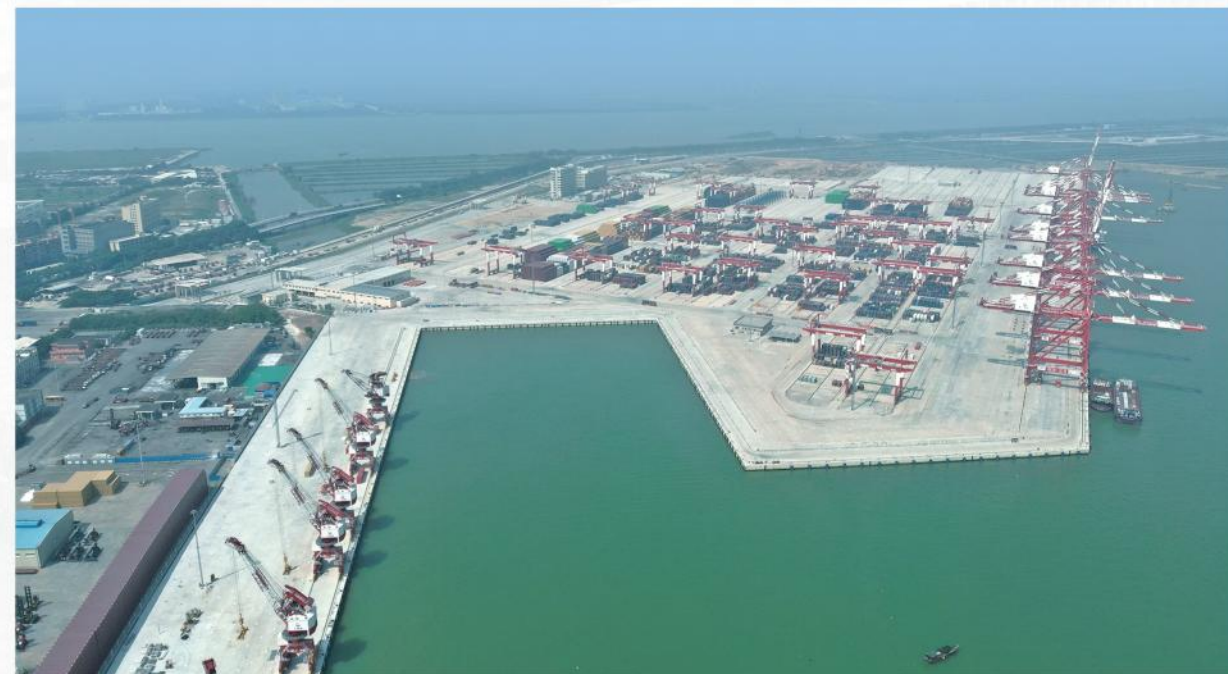
喀麦隆克里比深水港地基检测； 桩基检测
