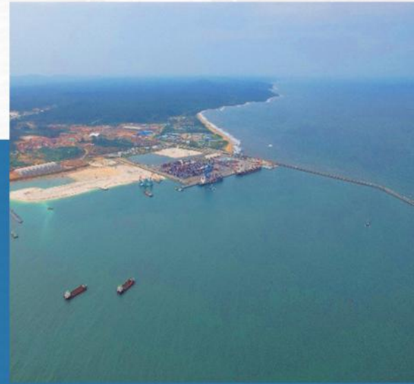
广州港南沙港区二、三、四期科研监测、 地基基础检测
