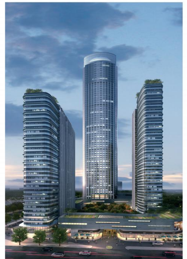
中交汇通·横琴广场基坑 支护及桩基础工程
