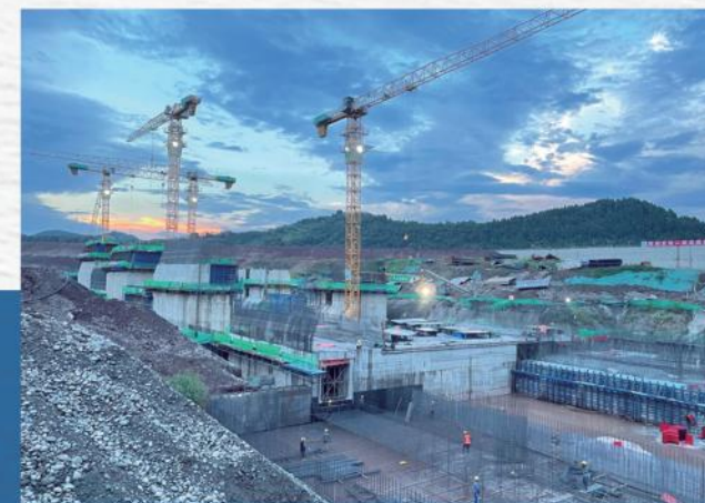
渠江风洞子航运枢纽工程结构安全检测 大体积混凝土控裂及质量控制
