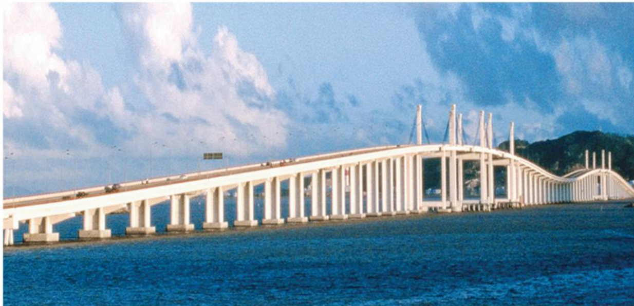
澳门友谊大桥混凝土防腐涂装工程
