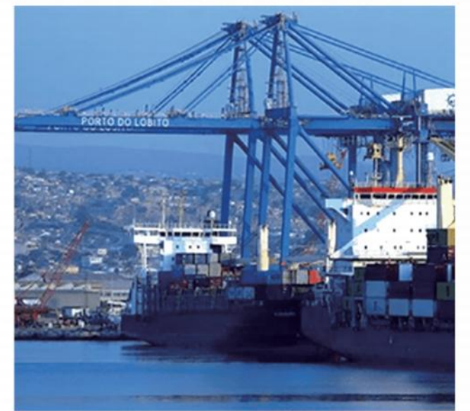
安哥拉洛比托港扩建工程地基与桩基检测
