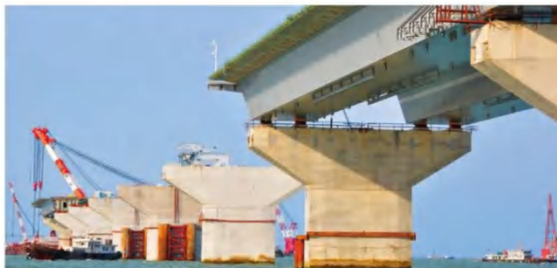
港珠澳大桥主体工程桥梁工程CB04标合同段 混凝土硅烷检测
