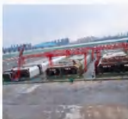
江西南昌红谷隧道沉管管节裂缝控制
