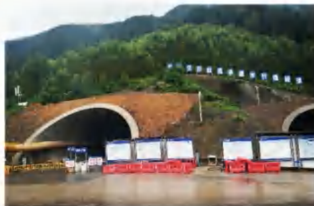
广东省开春高速公路水竹塘隧道超前地质预报及施工质量检测与监测
