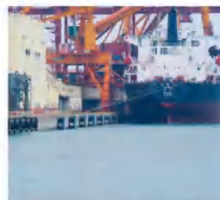
汕尾电厂码头结构检测与评估
