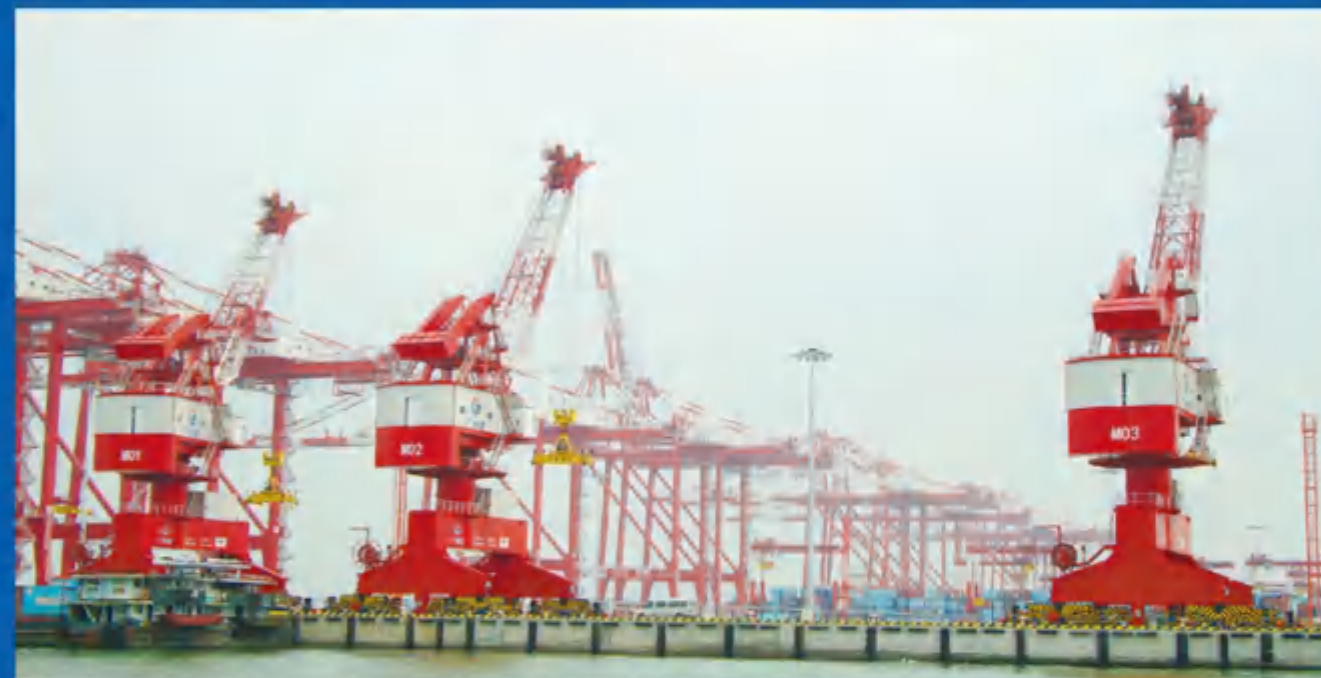
广州港南沙港区三期工程监（检）测
