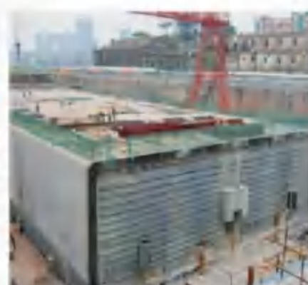
广州洲头咀沉管隧道预制沉管温度应变监控及控制
