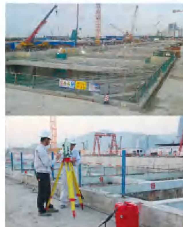
珠海市区至珠海机场城际轨道交通拱北至 横琴段项目工程施工监测
