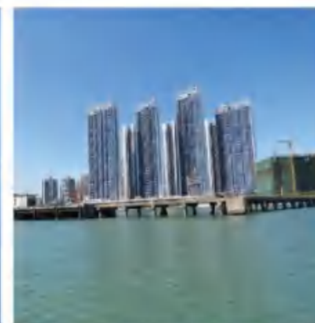
蛇口油库码头结构检测
