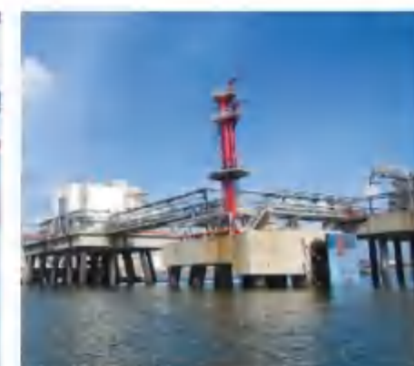
马鞭洲码头升级疏浚工程码头结构检测与评估
