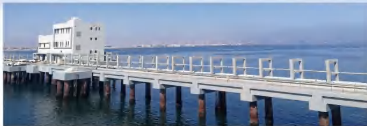
纳米比亚国家储油设施码头项目低应变、超声波桩基检测
