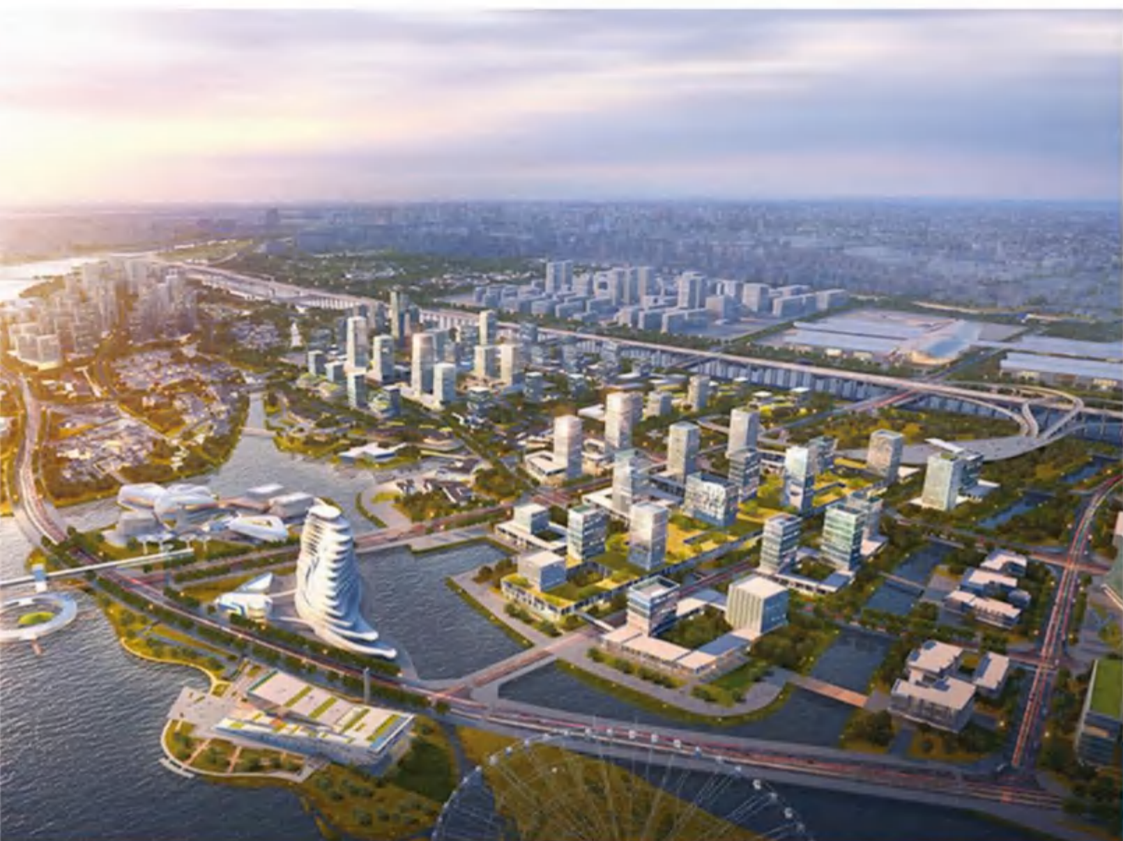
深圳市海洋新兴产业基地陆域形成工程监测检测项目 Land formation Engineering of Marine Emerging Industry Base in Shenzhen to Zhongshan
