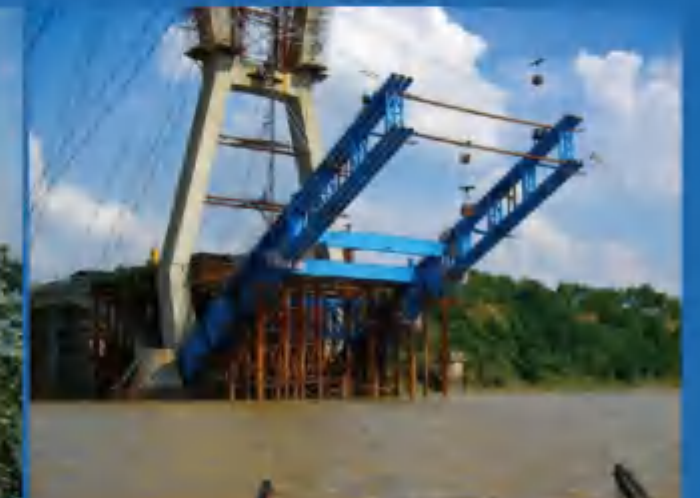
湘潭莲城大桥桥梁施工监控，荷载试验、
