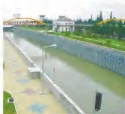
京杭运河淮安三线船闸大体量混凝土控温控裂
