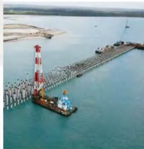
肯尼亚拉姆港1-3号泊位项目 Berth 1-3, Lamu port, Kenya
