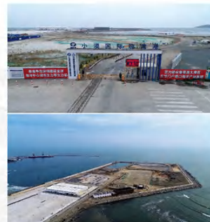
深汕特别合作区 小漠国际物流港一期工程 Shenzhen Shantou Special Cooperation Zone Xiaomo International Logistics Port Phase I Project
