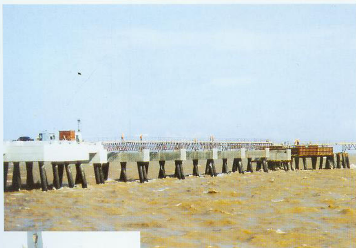
► 施工中的主引桥
