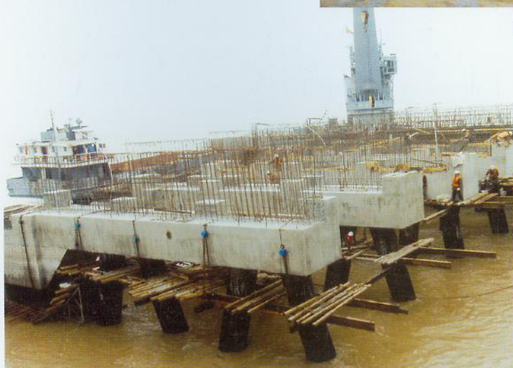
◀ 施工中的W2泊位
