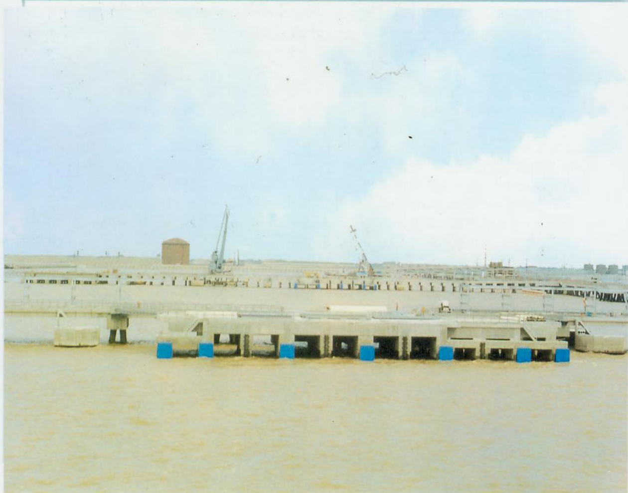
由四航局三公司承建的上海孚宝25000吨级液体化工码头工程
