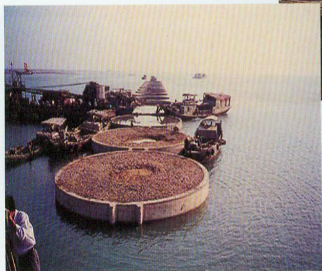
● 圆筒安装后及时进行筒内回填
