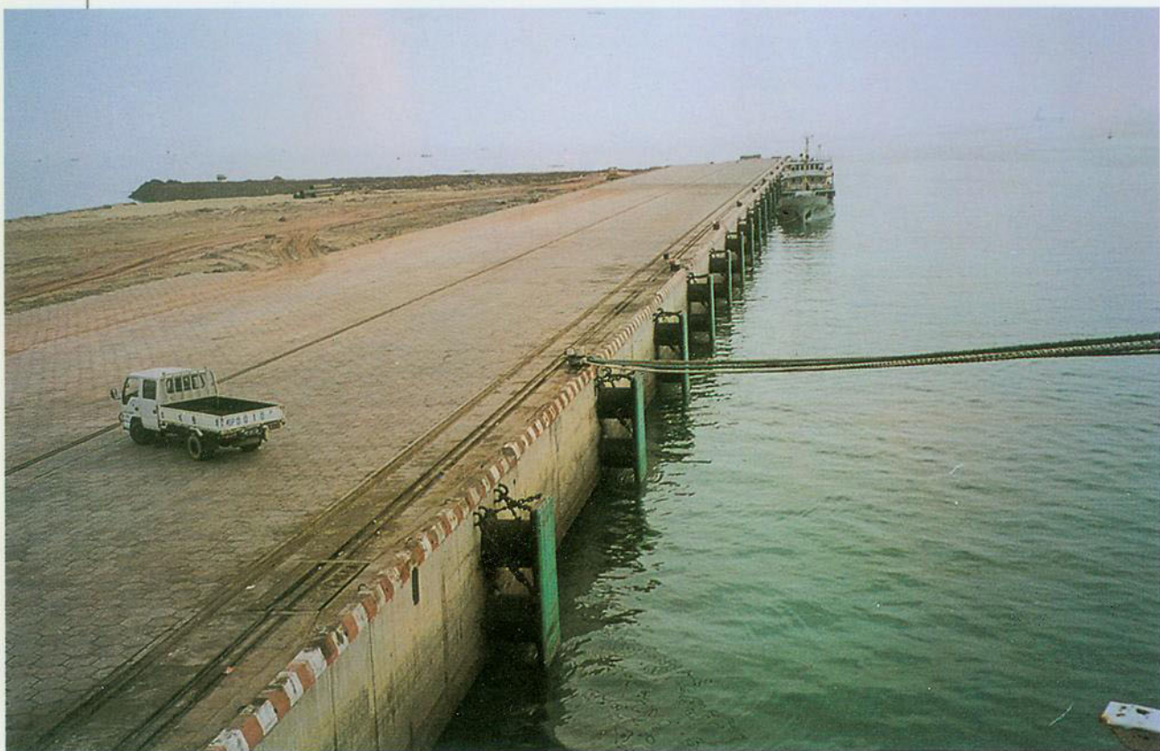
竣工后的广西防城港十一、十二泊位码头
