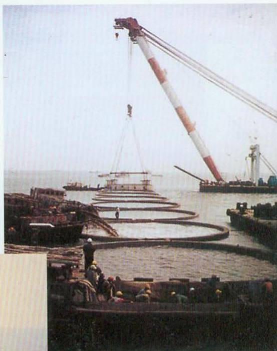
● 圆筒安装后及时进行筒内回填
