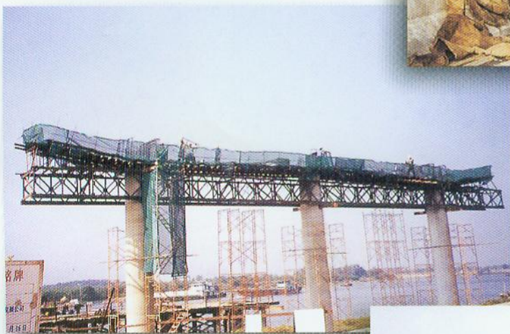
◀ 引桥盖梁施工
