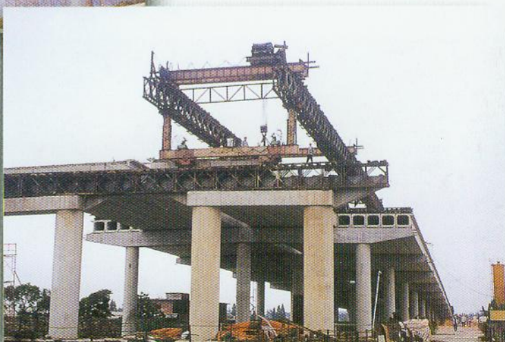
◀ 引桥盖梁施工
