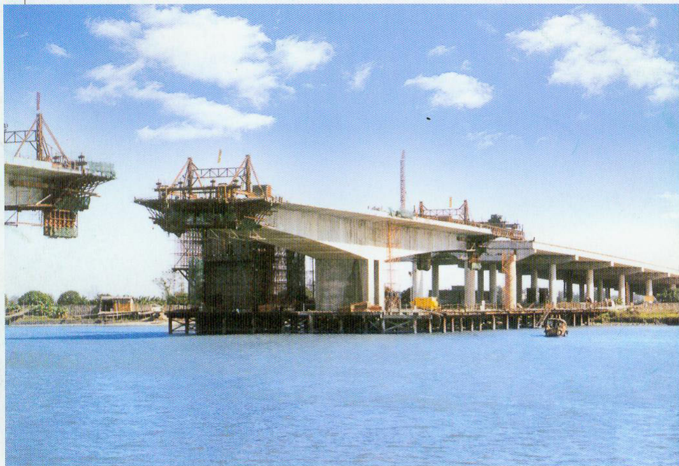
施工中的广和大桥
