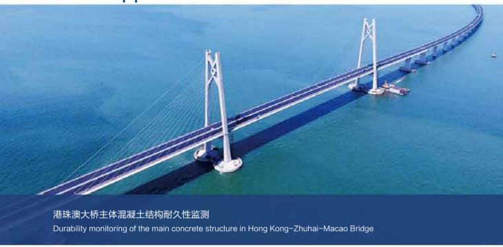
四航研究院针对港珠澳大桥耐久性突出问题,设置耐久性监测点,预埋先进的耐久性传感器,建立耐久性监测系统,实现监测数据的定期自动采集,整个过程无需人工干预,同时基于目前高速4G无线网络,可实现采集行为的远程控制及采集数据的远程获取。
