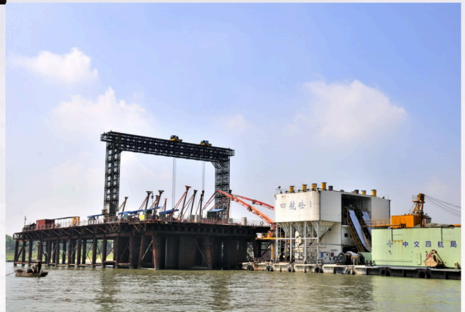
▲ 243号主墩首桩浇筑
