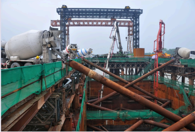
▲ 243号主墩承台浇筑
