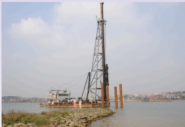
▲ 钢栈桥钢管桩沉桩
