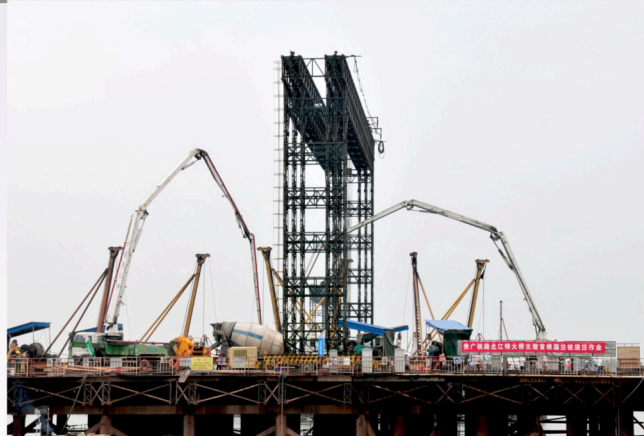
▲ 244号主墩15#桩浇筑 (贵广铁路全线首根桩长最长且直径最大桩基)
