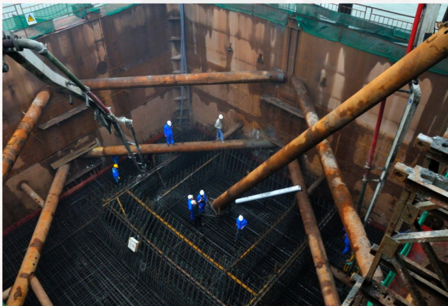
▲ 244号主墩承台 (长35m, 宽17m, 高6m, 砼方量达3570m 3 )
