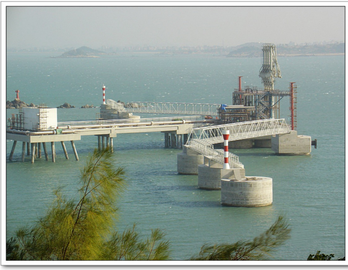
▲ 莆田LNG主码头
