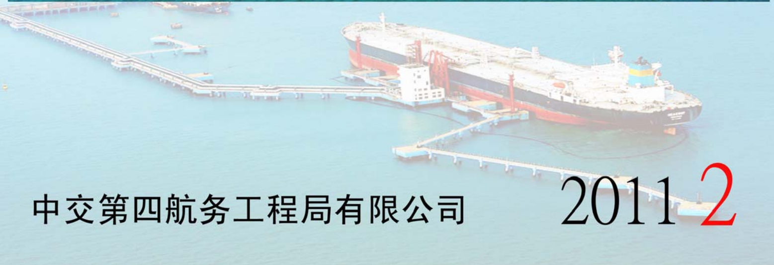
由中交四航局第三工程有限公司承建的湛江港油码头工程
