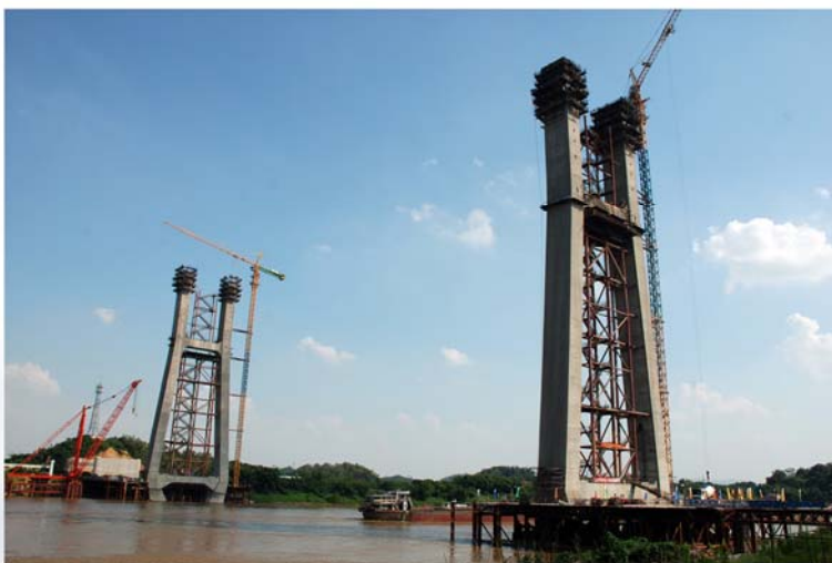
▲ 贵广铁路思贤滘特大桥主塔封顶
