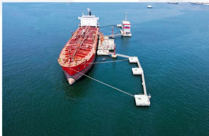
▲ 安哥拉油码头工程
