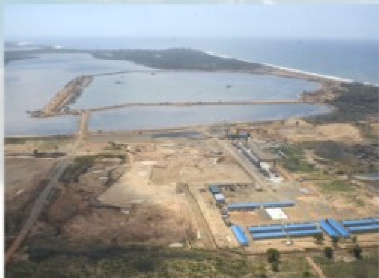
▲ 汉班托塔港一期工程航拍现场
