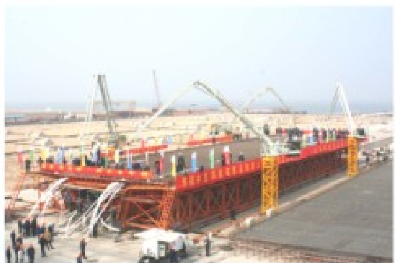
▲ 60m预制箱梁混凝土浇筑
