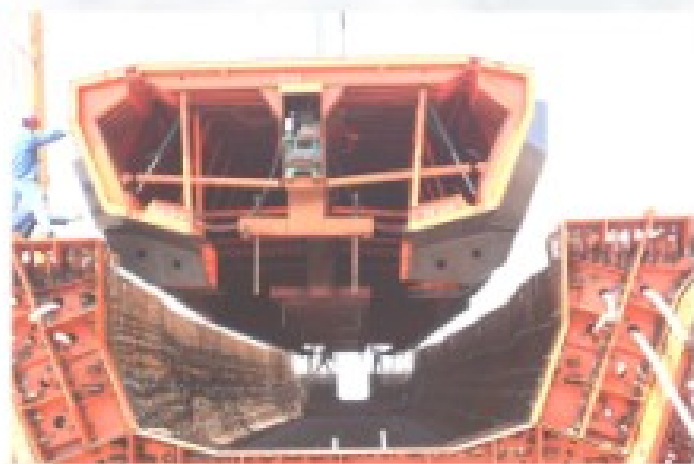
▲ 箱梁内模整体吊装
