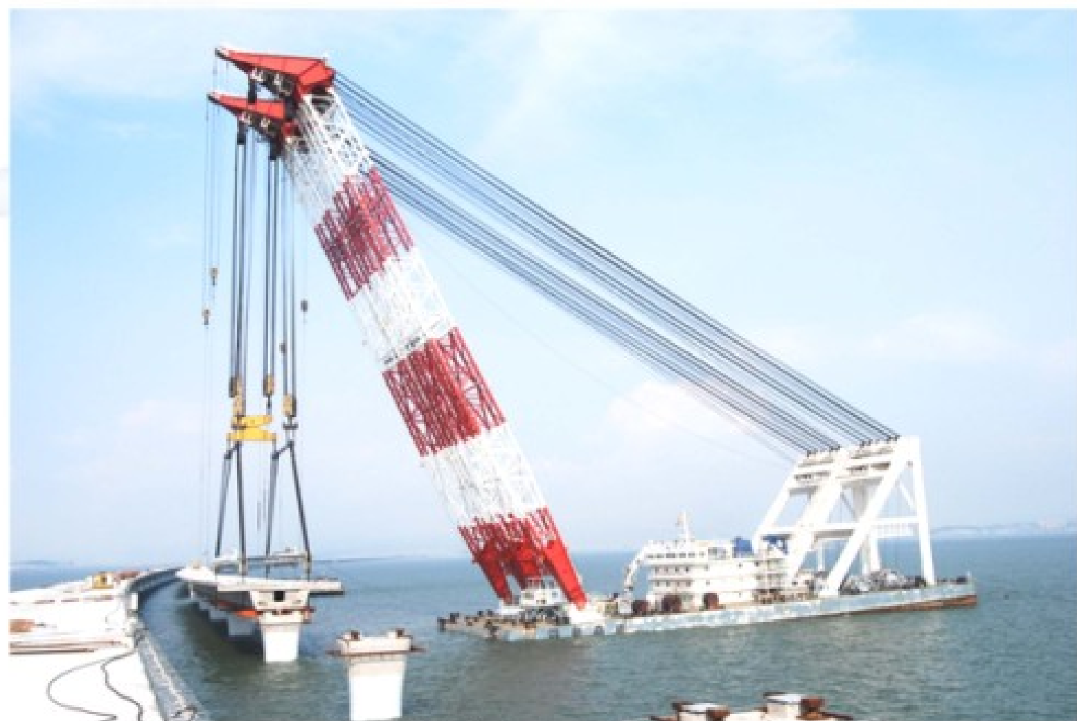
施工中的青岛海湾大桥—2600t起重船吊装60m箱梁
