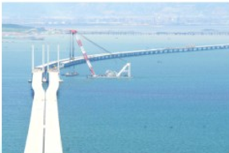
▲ 非通航孔桥60m混凝土箱梁吊装俯瞰
