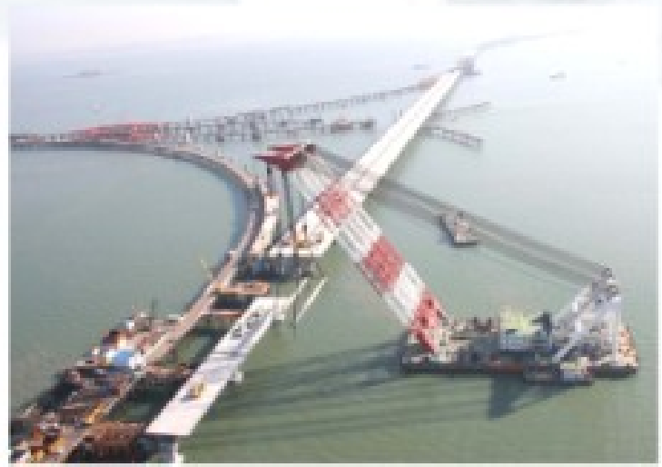
▲ 红岛互通立交主线桥60m混凝土箱梁吊装
