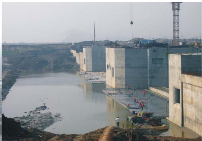
▲ 船坞卧倒坞门安装
