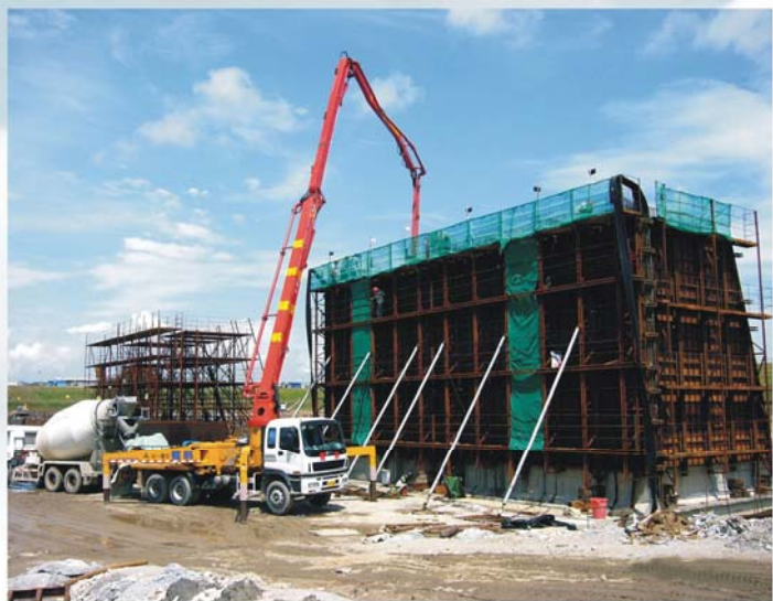
▲ 坞墙扶壁浇注工艺
