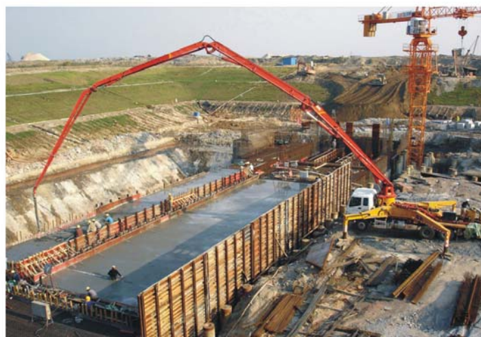
▲ 坞口底板混凝土浇筑
