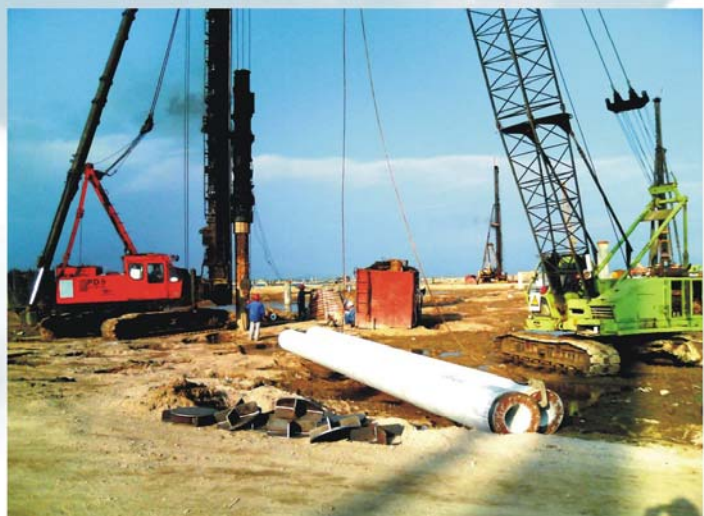
▲ PHC桩超深送桩工艺施工
