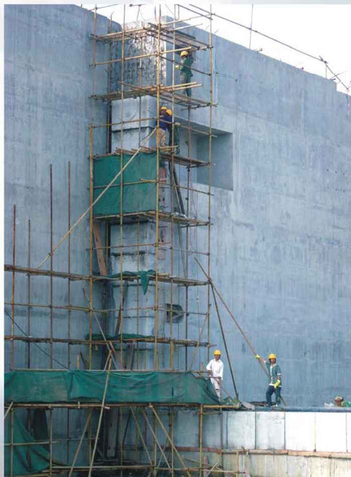
▲ 坞口镶面花岗岩安装
