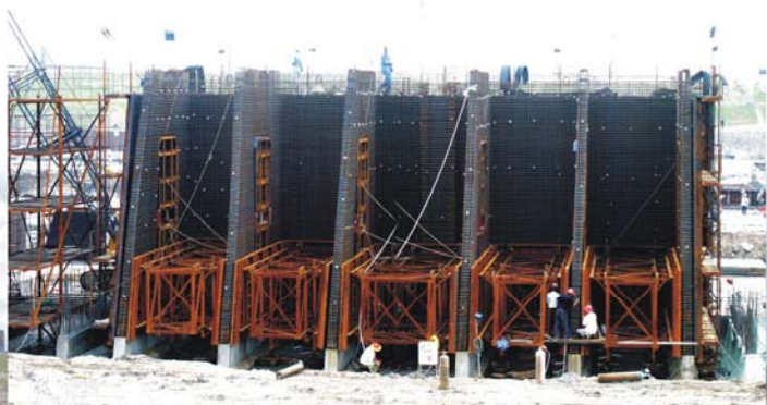
▲ 船坞扶壁模板安装工艺
