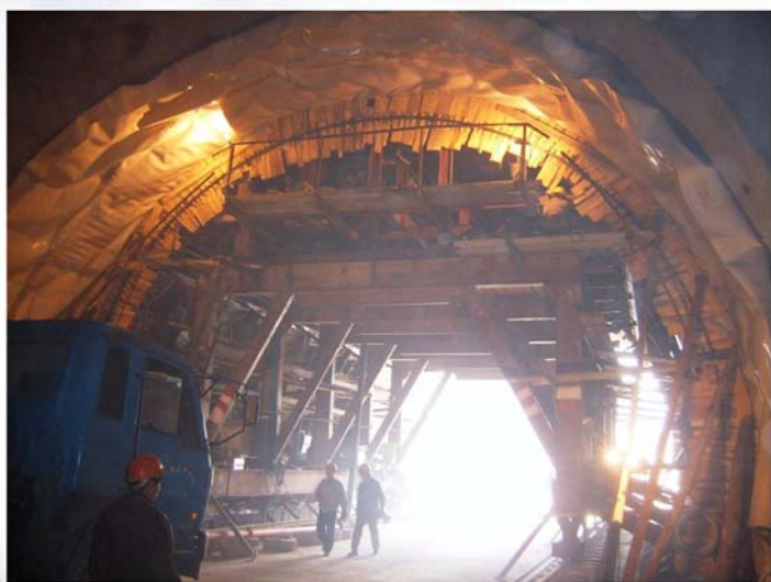
▲ 隧道二衬施工
