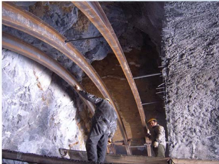
▲ 洞口段拱顶溶洞
