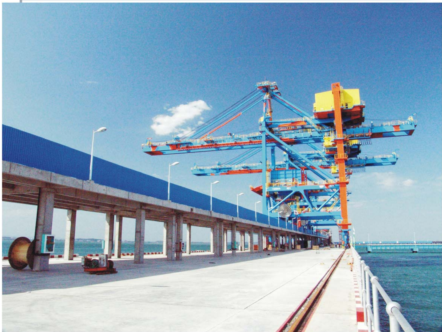
广西防城港电厂码头
