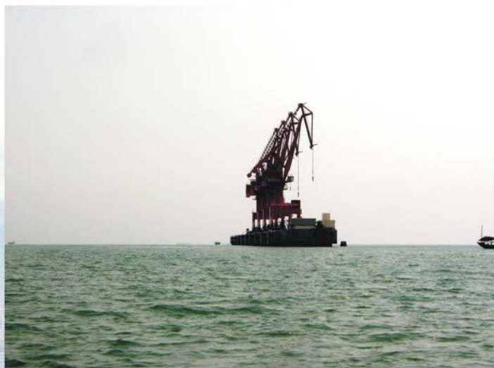
▲ 广西防城港20万吨级码头
