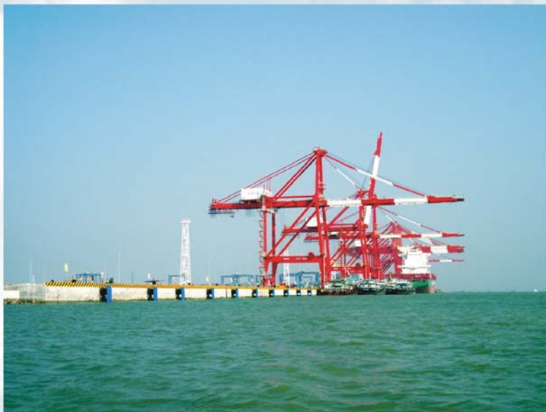
▲ 广州港南沙港区一期 3号、4号泊位工程
