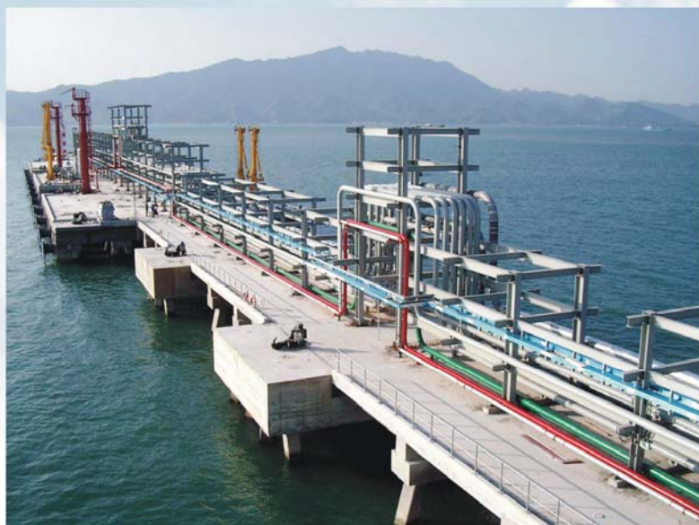
▲ 广东惠州港3万吨级石化码头
