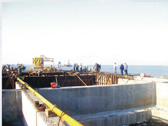
▲ 泵送现浇卸荷板混凝土
