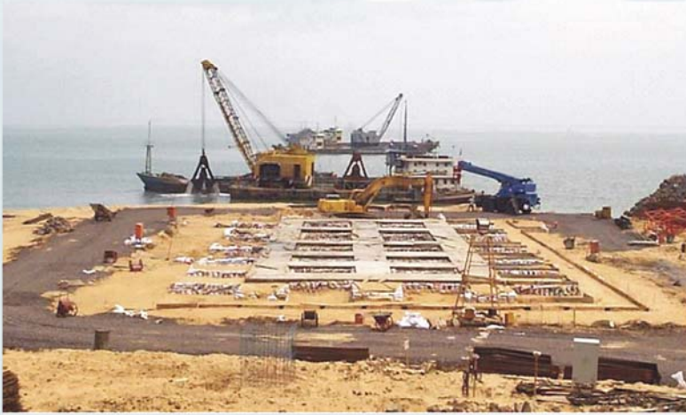
▲ 沉井混凝土垫层
