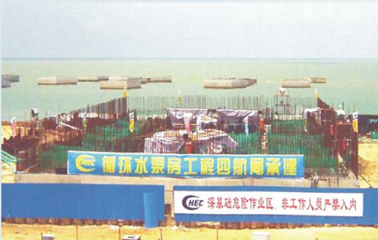
▲ 沉井下沉到位
