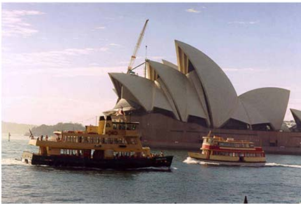
悉尼歌剧院修复工程采用全自动 监控电化学防护系统技术
