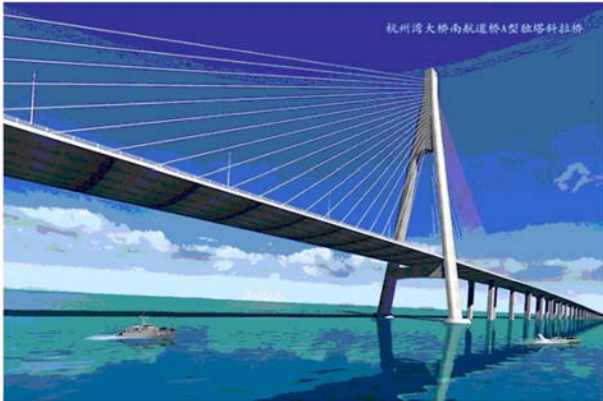
杭州湾大桥索塔的钢筋混凝土 全自动监控电化学防护工程
