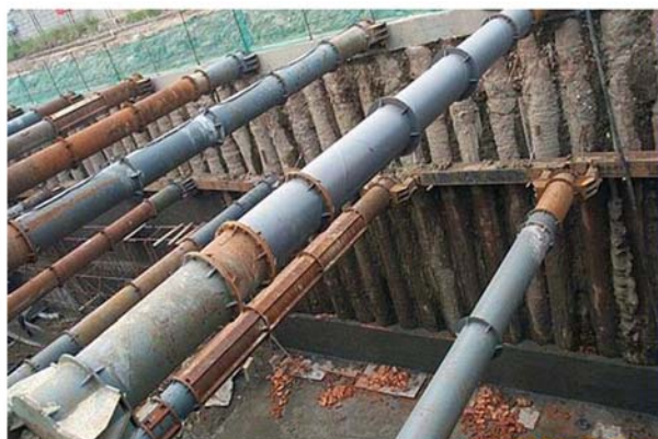
深基坑支护监测
