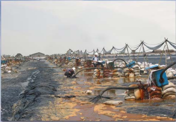
真空预压软基处理
