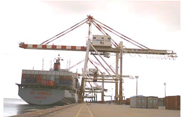
布里斯本港修复工程成功运用 电化学防护系统技术
