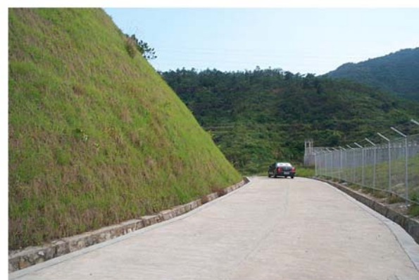
高边坡加固及生态护坡
