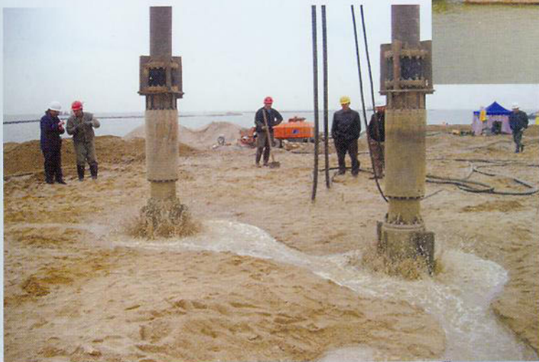
◀ 回填砂振冲密实加固处理
