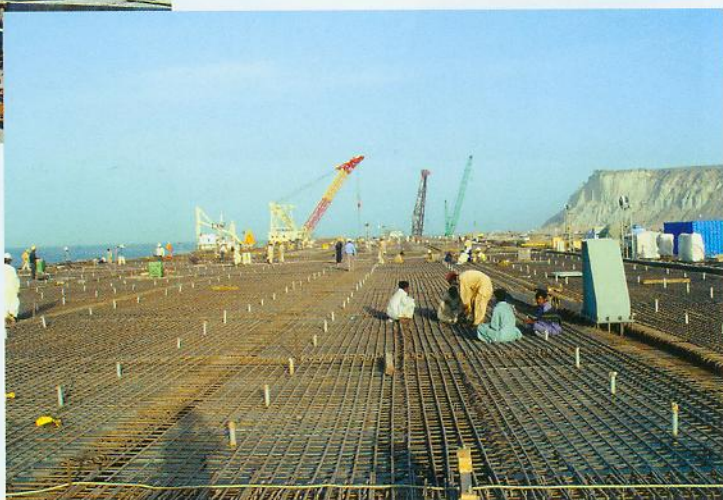
面层钢筋绑扎 ▶
