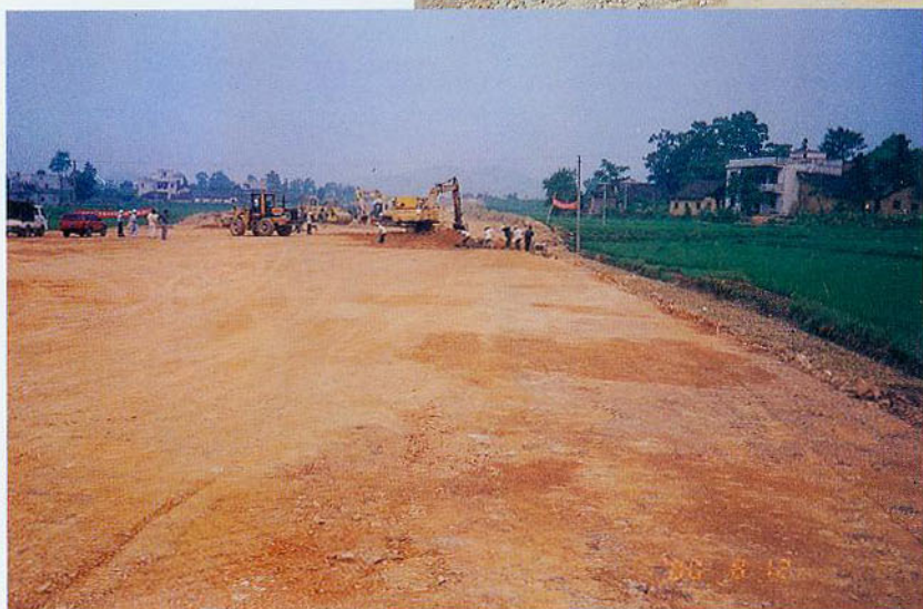
● 路基土方施工
