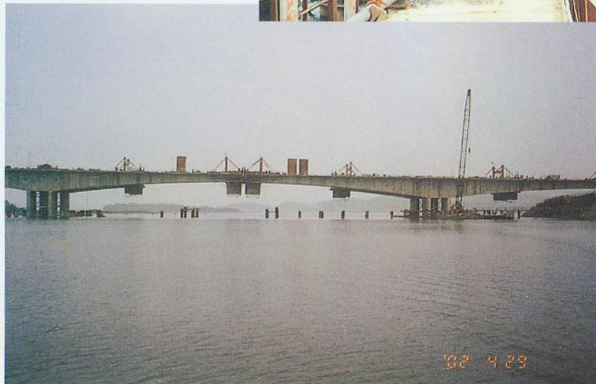
● 大桥中跨合拢
