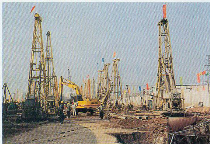
● 围护结构灌注桩施工
