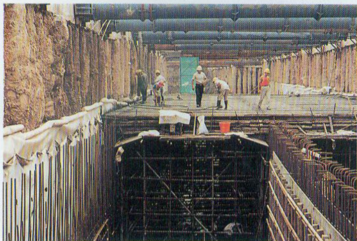
● 主体工程施工
