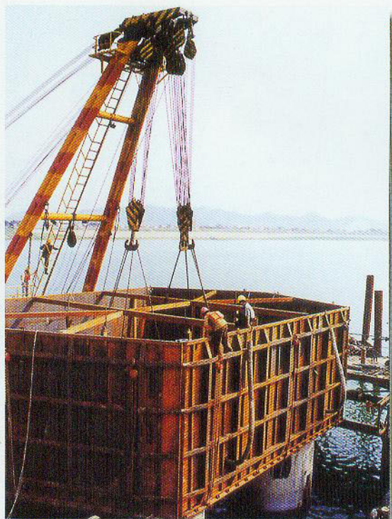
▲ 主墩承台套箱整体吊装
