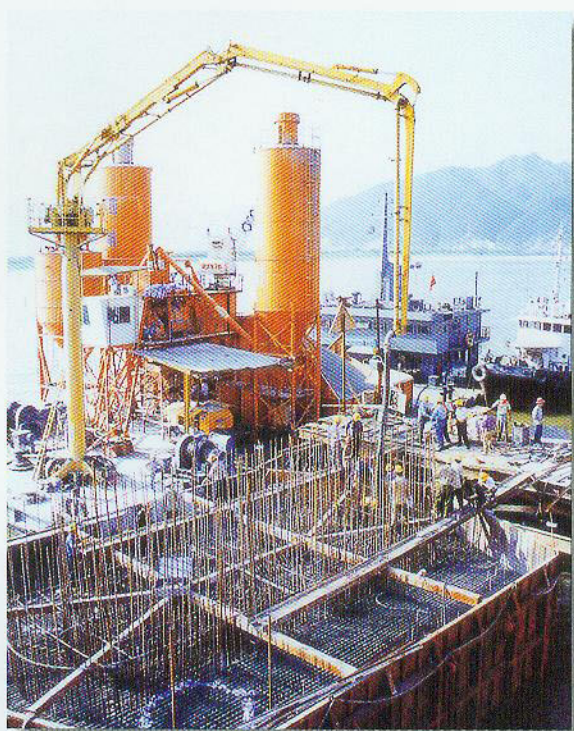
▲ 主墩承台施工
