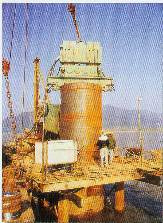
▲ 美国进口 377kW 振动锤下放 \phi 3150 内护筒
