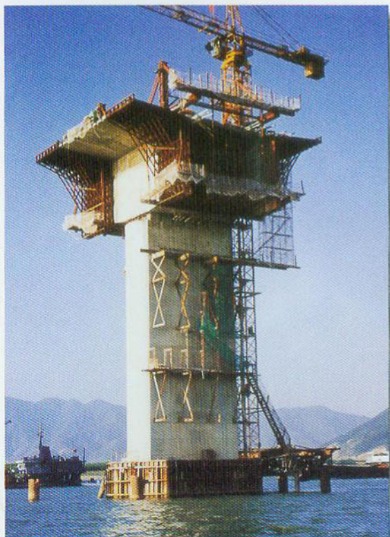
▼ 主墩挂篮安装
