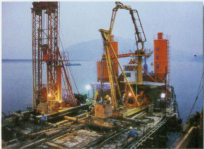
▼ 41#墩 C 桩浇筑混凝土现场
