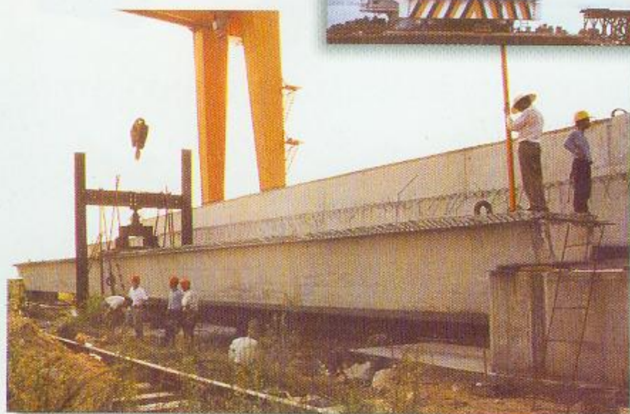
◀ 结构应力应变检测—广州内环 路预应力箱梁静载试验
